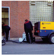
Czyszczenie suchym lodem
